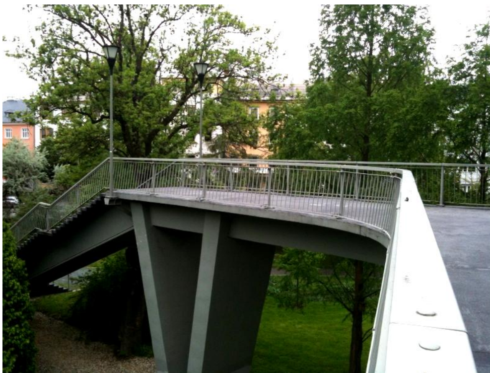
Obrázek 18: snímek mostu, nástup přes schody.
